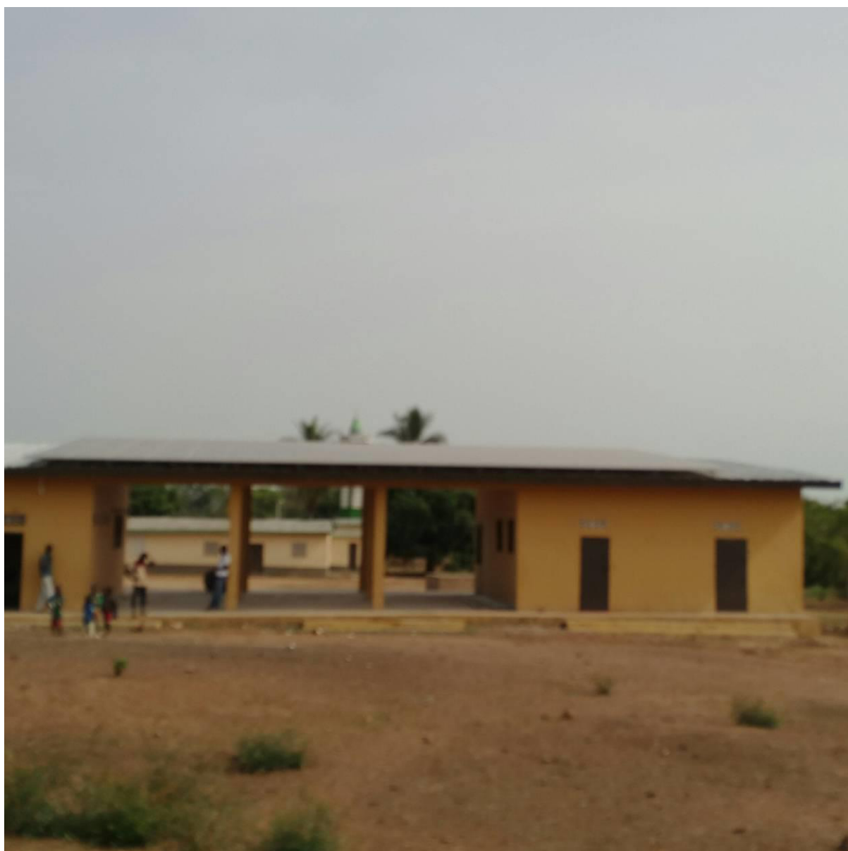
Photo 4 : Maison de l'énergie de Kakpin
