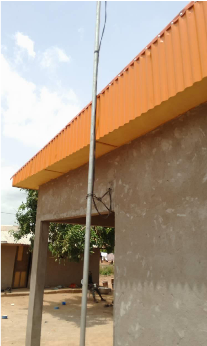
Photo 8: Poteau de raccordement électrique au maison des abonnés
